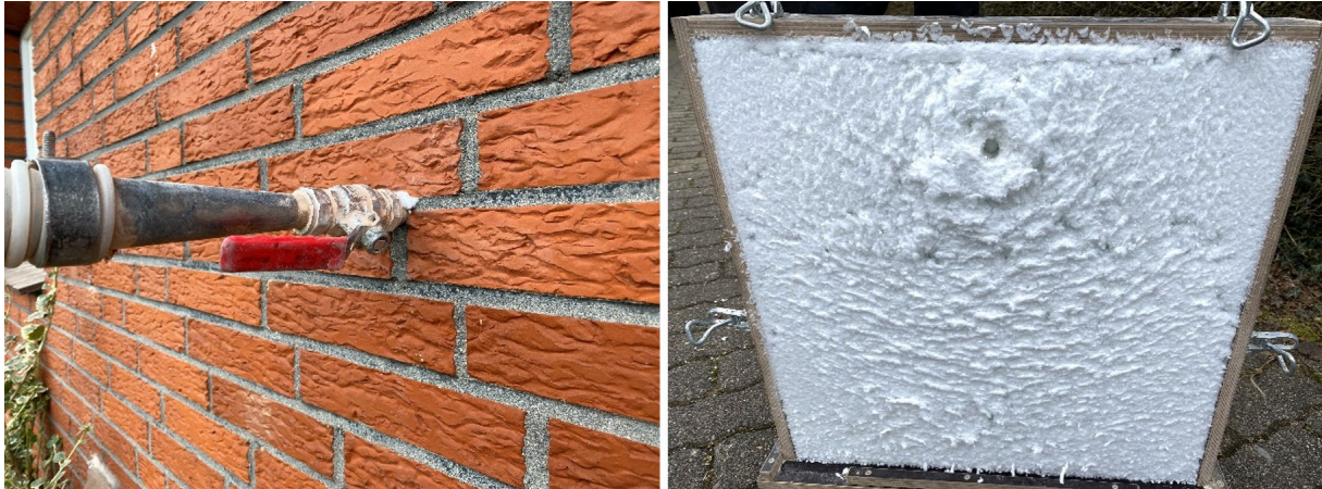
Abbildung 13: Einbringen der Kerndämmung von außen (links), Eingespritztes Dämmmaterial: Mineralfaser der Wärmeleitstufe (WLS) 035 (rechts)
