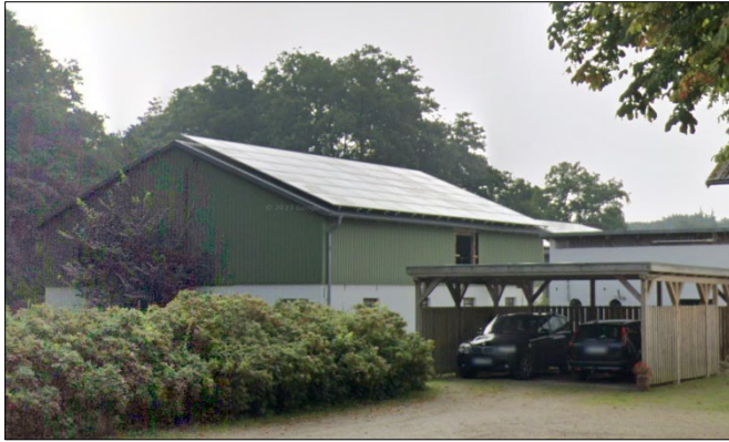
Abbildung 9: Photovoltaik-Anlage auf dem Dach im Quartier (Quelle: Google Street View)
